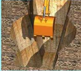
Excavar una zanja, como mínimo dejar 40cm entre pozo y paredes de la zanja.
