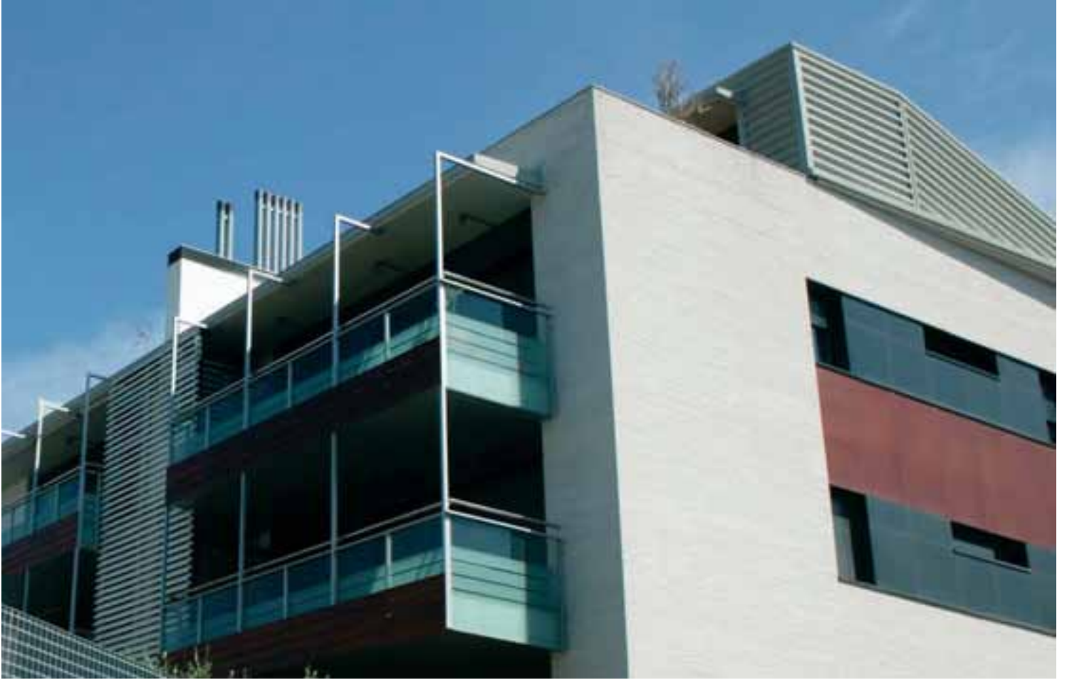
Viviendas en Tiana, Barcelona. Eduard Sabater. Ladrillo Hueco. Ref. Blanco Mármol Obra finalista en categoría de obra privada en la Trienal de Arquitectura del Maresme 2004
